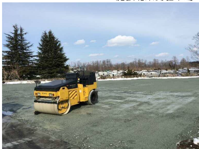
施設北東側駐車場
