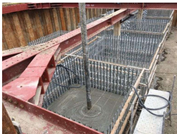
余熱利用設備棟コンクリート打設状況
