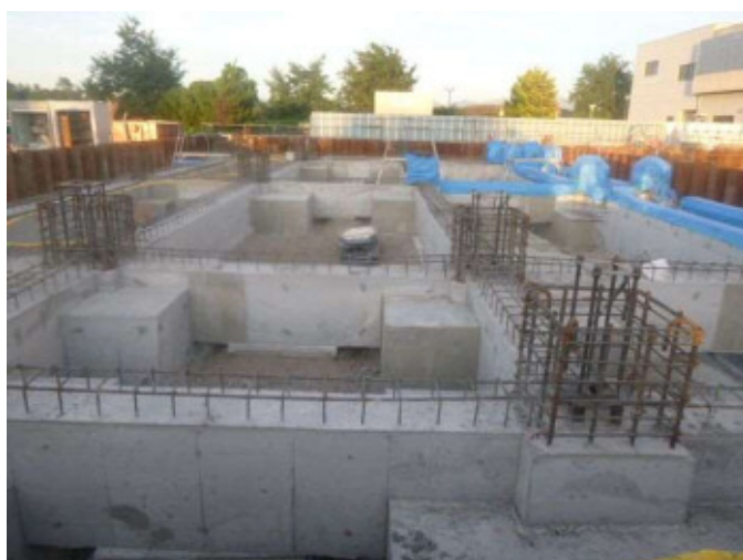
蒸気復水器棟基礎躯体施工状況
