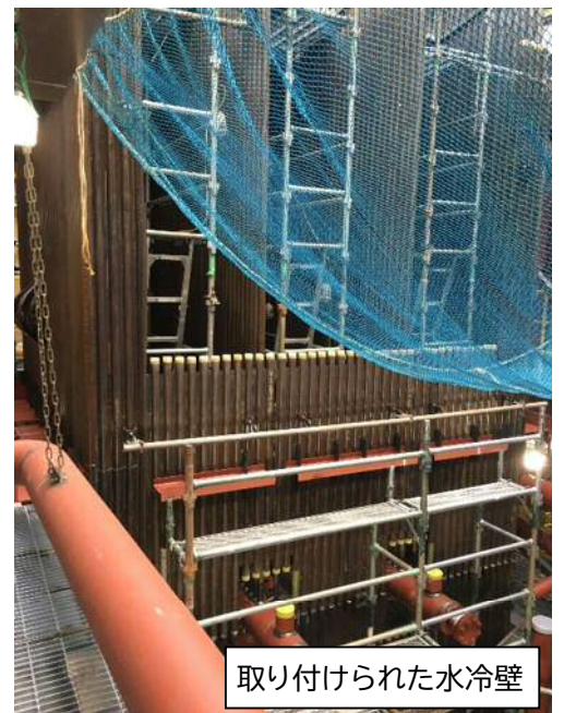
汽水胴の取込みの様子
