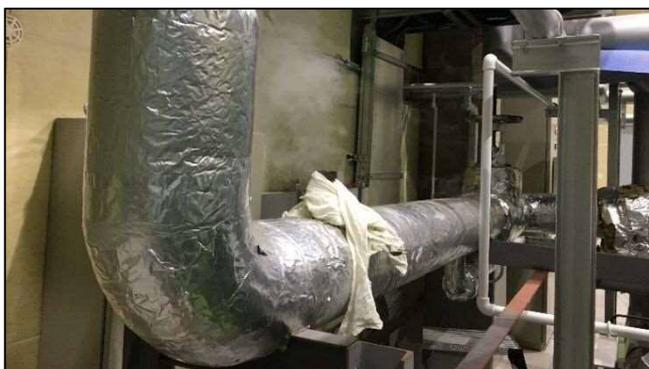
設備の各種運転調整が行われています。写真は配管内に蒸気を流して洗浄する「蒸気フラッシング」の様子。
