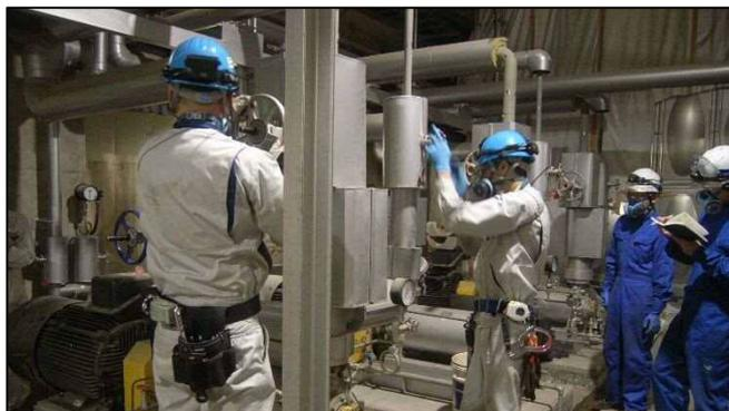
運転調整と同時に、機器の運転管理についての実機研修が行われています。写真はポンプの水抜き方法の研修を受ける様子。
