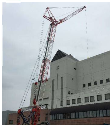
仮設屋根の搬入作業を行う様子
