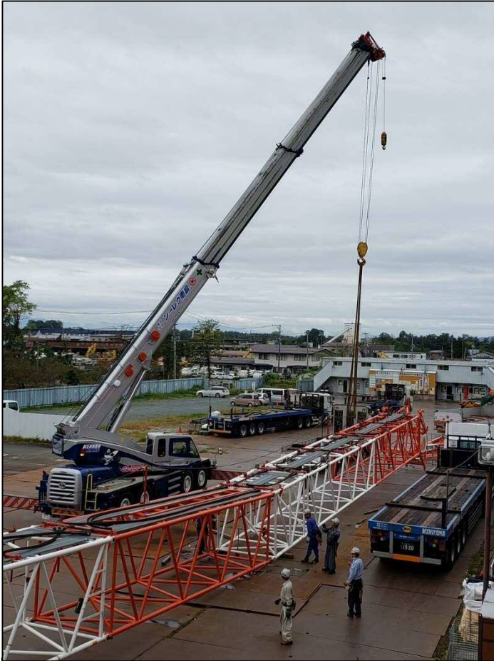
小型クレーンによる大型クレーンの解体
