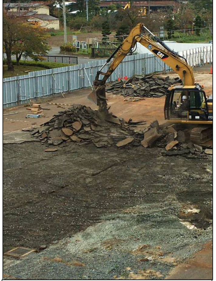
劣化したアスファルトの撤去作業
